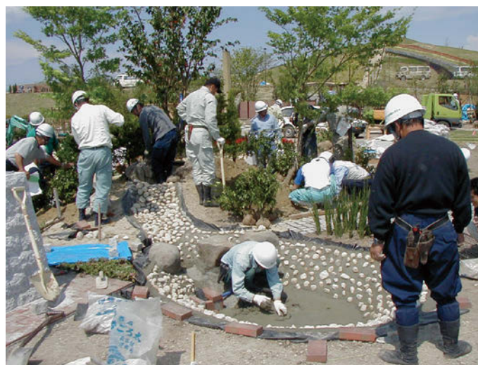
青年部・全国都市緑化やまがたフェア庭園施工（平成14年）
