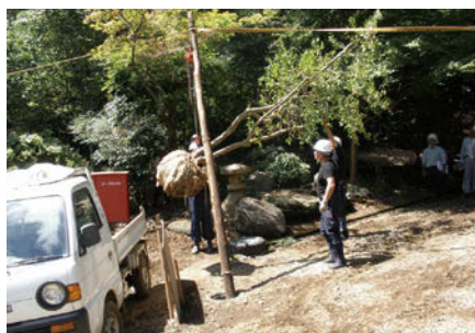
【上】ぼうず(一本柱)による樹木の移動 【左】丸太によるかつぎ
