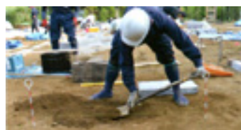
①施工範囲の床掘りを行う
