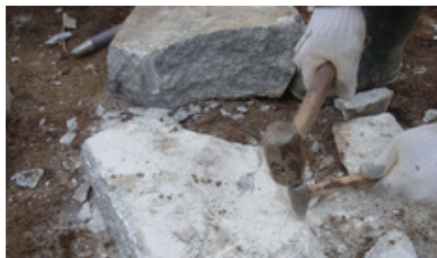
石目をよく見て、石目に沿って割ると、凹凸が少なく滑らかな断面となる
