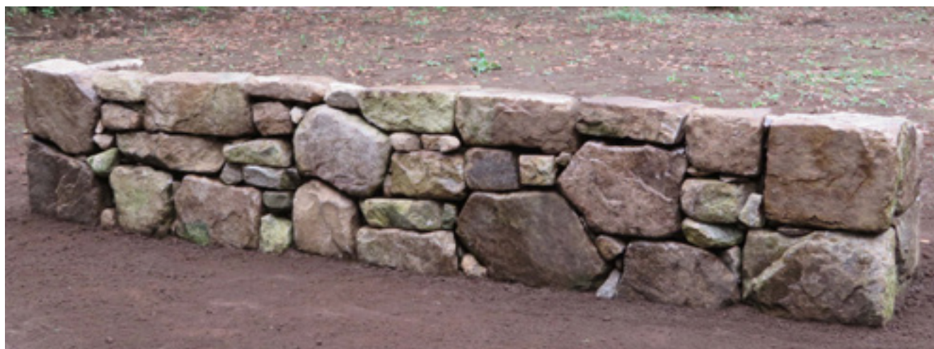
完成した野面積み。下の2石で上の1石を支え、また目地の模様注意到積み上げた
