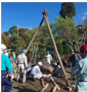
三又による石の運搬作業
