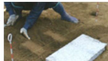
①施工範囲の床掘りを行う
