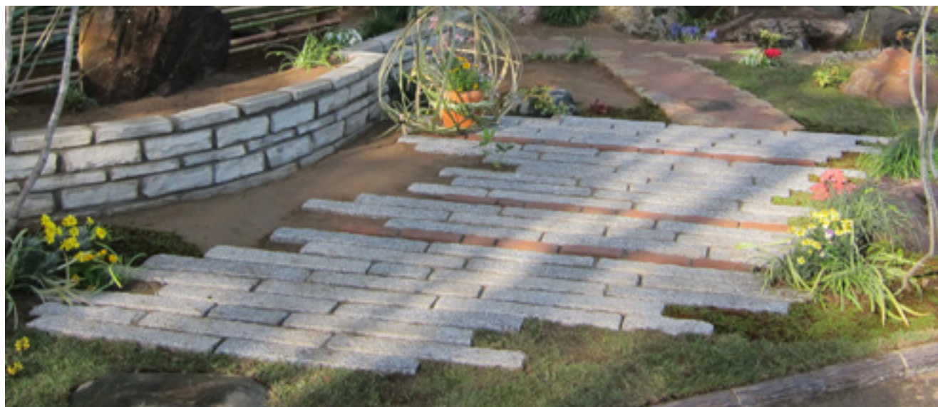
切石をテラス風の敷石。ポイントにレンガを敷き、変化あるアプローチガーデンとする
