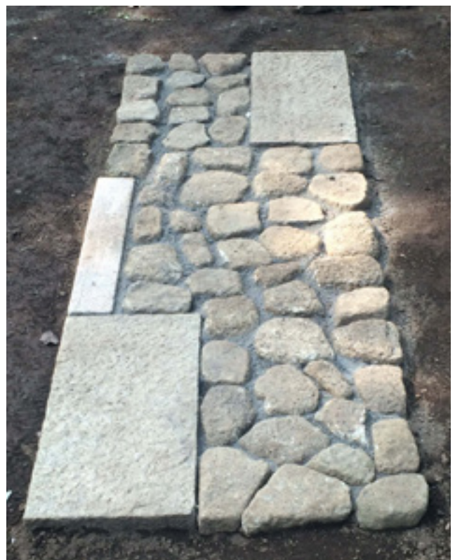
よくない延段の目地。四つ目地、通し目地が見られる
