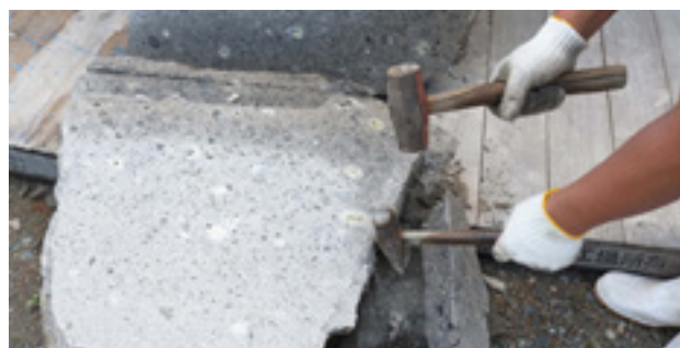
セットウでコヤスケを叩くときは、セットウの重みを利用して、リズムカルに強弱をつけて軽く叩くのがきれいに割るコツ
