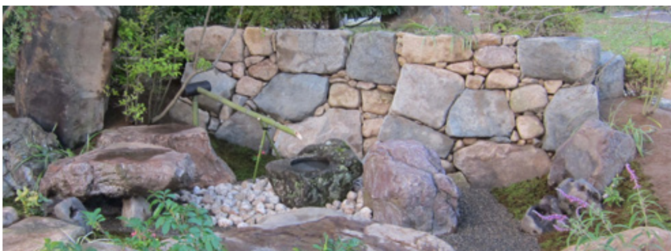
城壁を意識した野面積み。自然石の風合いを生かして積まれ、つくばいや草花と程よく調和している
