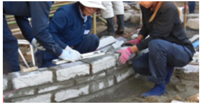
切石を用いた練積みの小端積み。水平を確認して積む
