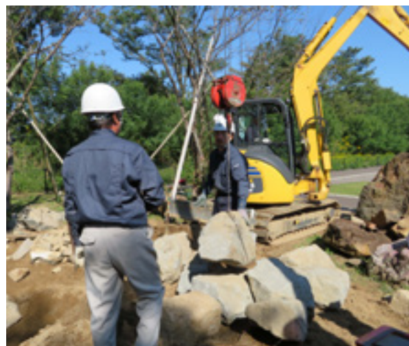
石を吊るときは周囲に注意し、安全に確実に誘導する
