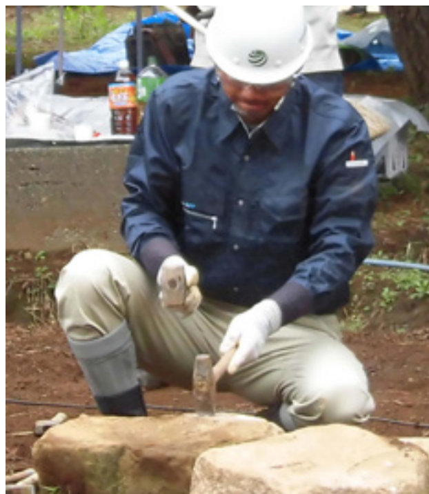
コヤスケとセットウで石を割る作業
