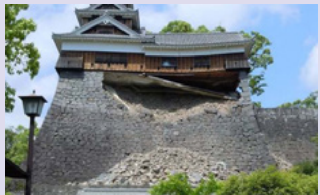
地震で崩落した熊本城の石垣
